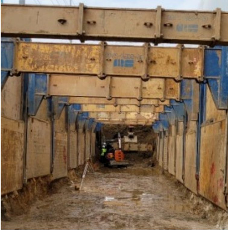
가시설 내부 굴착 및 PC 암거 시공 구간 선형·굴착 깊이·지하수·주변 구조물 조건을 종합 검토
