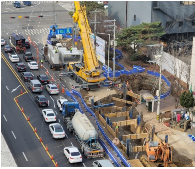
PC 암거 반입·거치 및 양중
