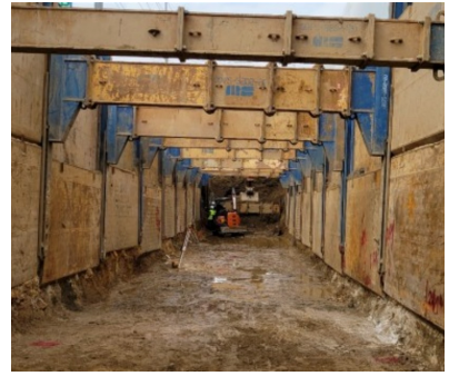
가시설 내부 굴착·정밀 시공
